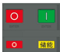
断路器断开且已储能完毕状态
