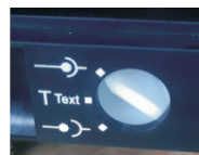
在“连接”位置，主电路及二次回路均接通
