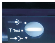
在“试验”位置，主电路断开，二次回路接通
