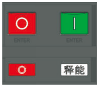
断路器断开且无储能状态
