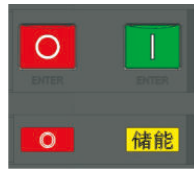
断路器断开且已储能完毕状态
