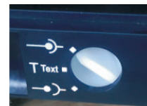
在“连接”位置，主电路及二次回路均接通
