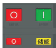
断路器断开且已储能完毕状态
