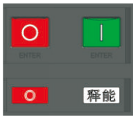
断路器断开且无储能状态
